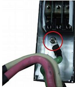
6. Befestigen Sie die Ringkabelschuhe der restlichen Drähte am Klemmenblock, und ziehen Sie jeden einzelnen mit einem Drehmomentschraubendreher fest. Die Anzugsmomente variieren abhängig von der Größe der Schraube.
